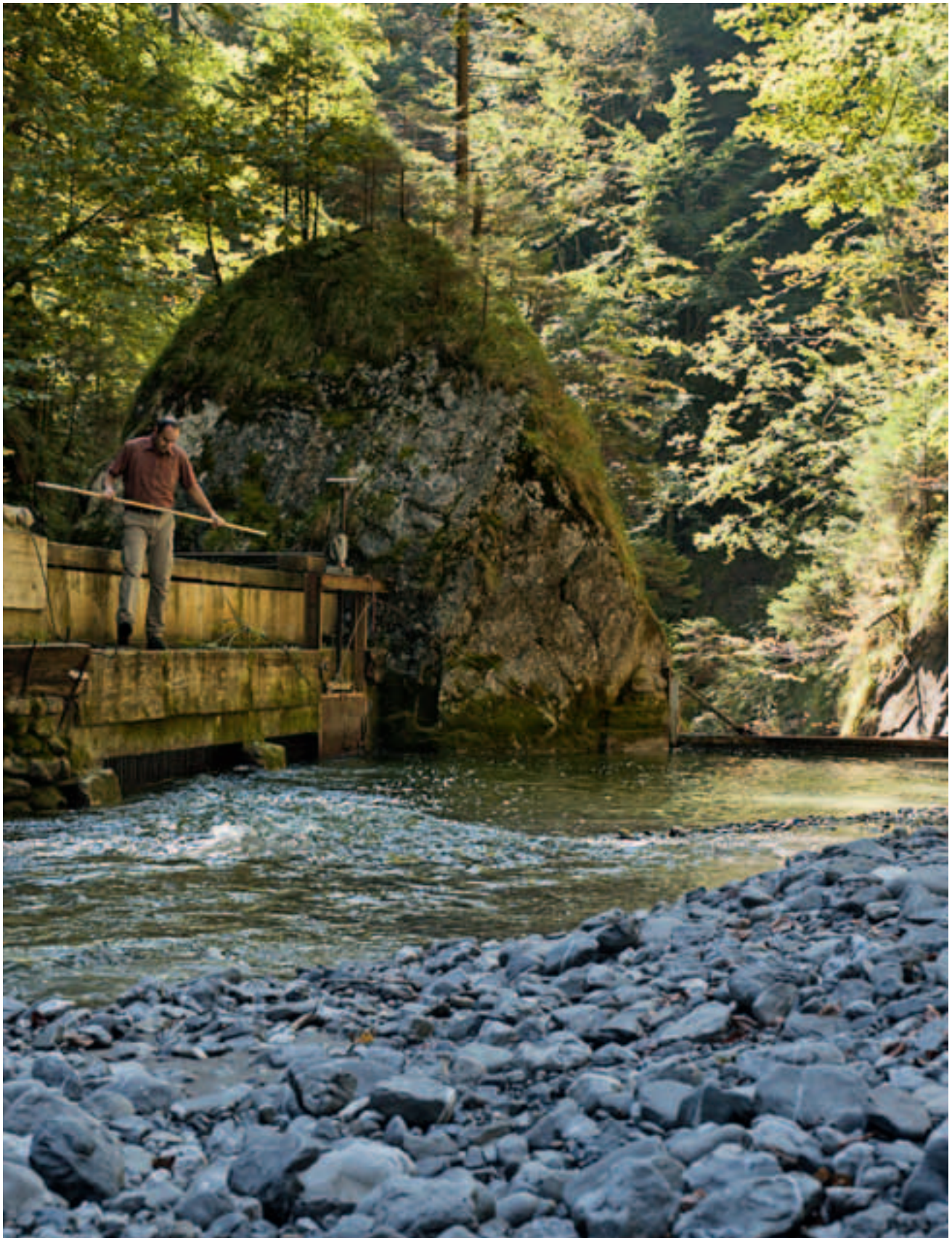
Vom Einlaufwerk fließt das Wasser durch den Wasserstollen zum Wasserschloss ...
