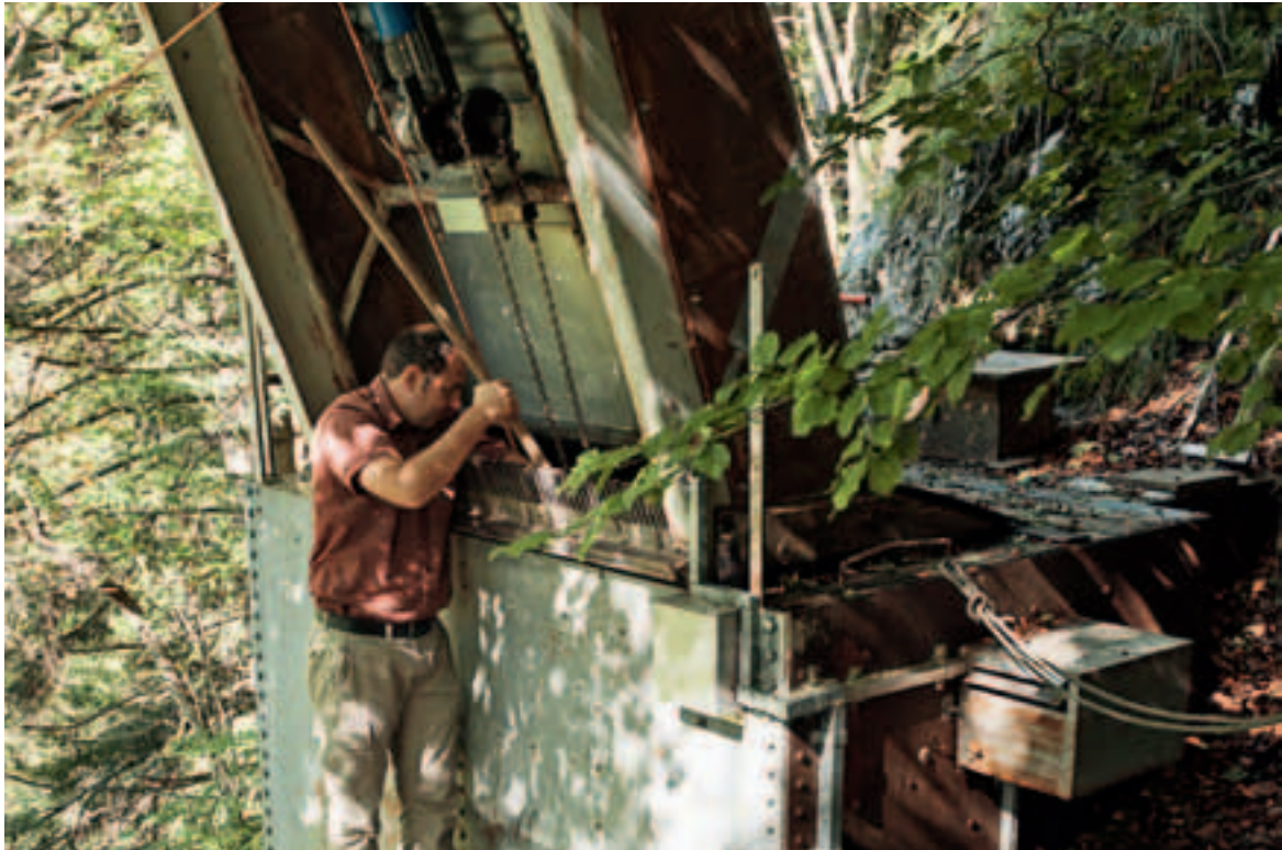
... vom Wasserschloss zur Druckleitung im Turbinenhaus
