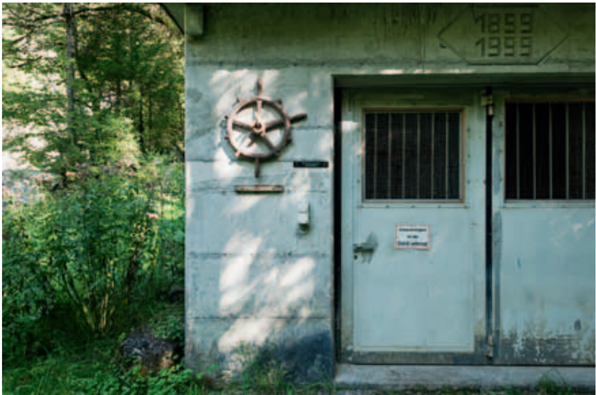
Im 1999 neu erstellten Turbinenhaus wird Weissenburger Ökostrom erzeugt
